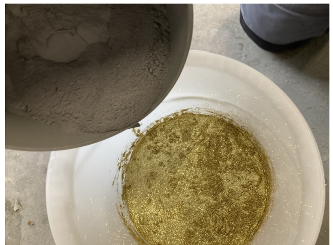
Der Fugenmörtel wird dem mit Glitter versetzten Anmachwasser zugegeben.
