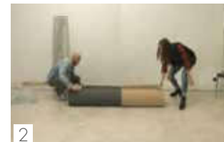
2 Stendere il tappetino Lay the underlayer
