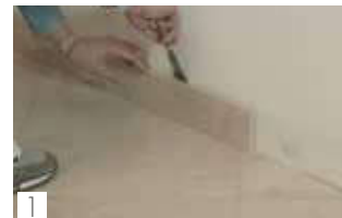
1 Eliminare il battiscopa Remove skirting
