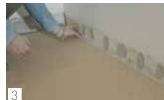
3 Posizionare i distanziali lungo il perimetro Fit the spacers around the outer edge
