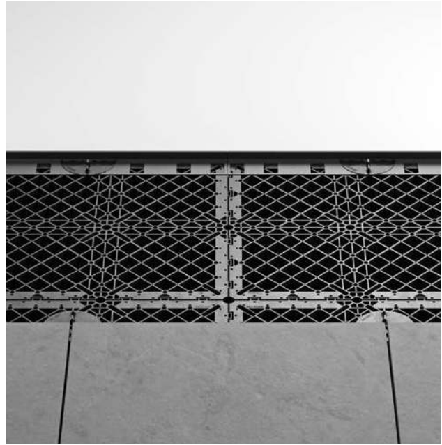
Positionnement du profilé sur les plots Positionierung des Abschlussprofils auf das Gitter
